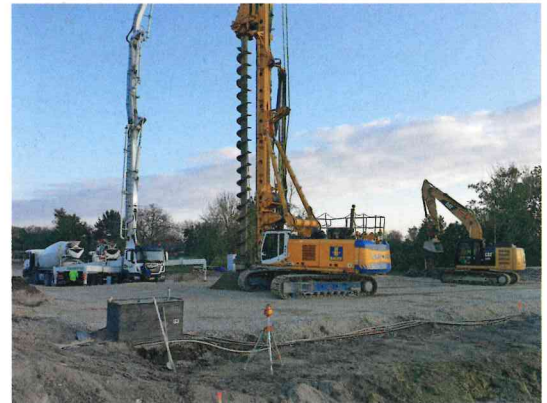
TIEFGEHEND Die Bauer BG 28 bei Arbeiten an der Unterführung am Bahnhof Untersiebenbrunn.
