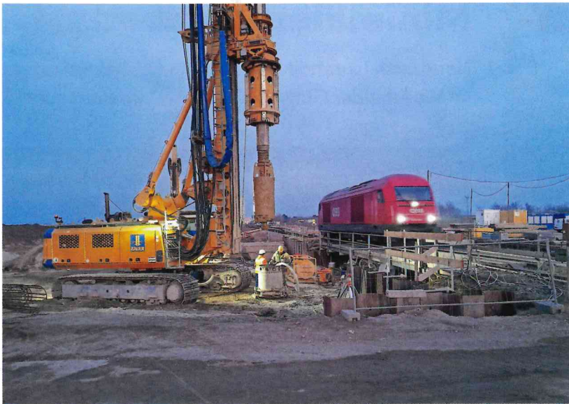
TIEFGEHEND Die Bauer BG 28 bei Arbeiten an der Unterführung am Bahnhof Untersiebenbrunn.
