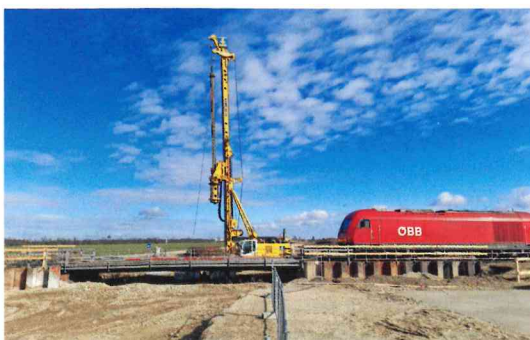
BETRIEBSAM Die Arbeiten an den Unterführungen werden bei laufendem Betrieb vorgenommen.
